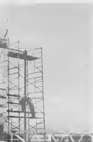
erect steel columns and beams. di columna y biganan di staal.
